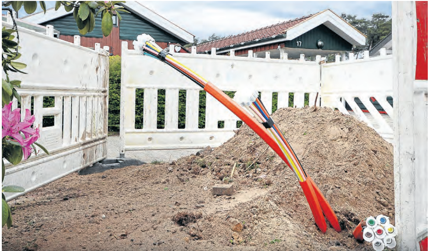
Beim Glasfaserausbau in den Außengebieten muss die Gemeinde einen langen Atem haben. Anfang vergangener Woche begannen die Arbeiten im Wochenendhausgebiet am Haddorfer See, hier am Rosengarten. Fotos: Sven Rapreger
