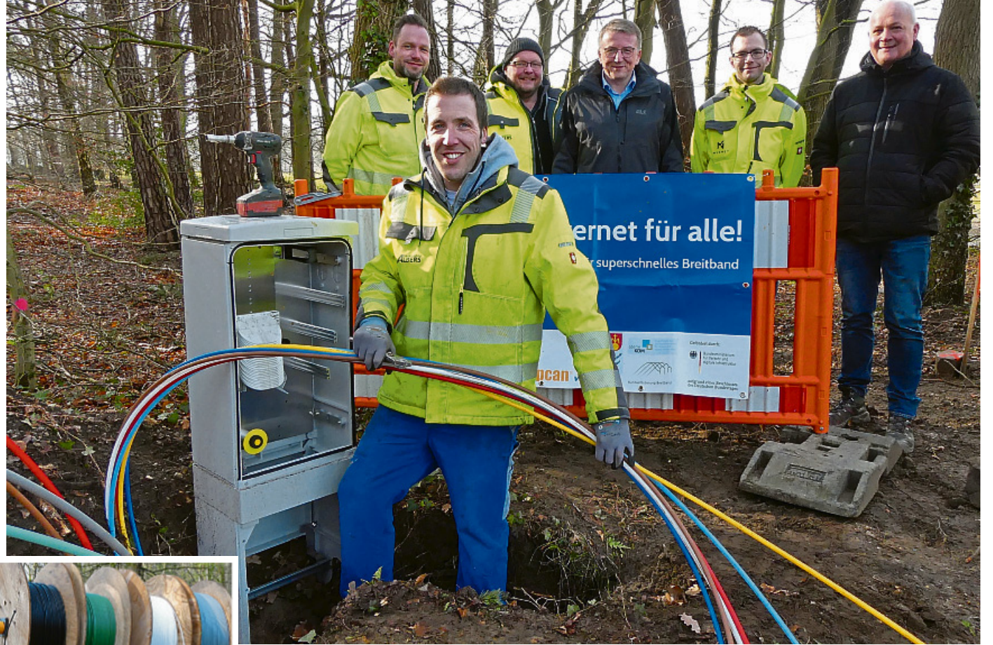
„Ich bin derjenige, der arbeitet.“ Die Stimmung war locker beim Termin auf der Glasfaser-Baustelle am Steinfurter Damm, zu dem sich (hinten v.l.) Carsten Dove und Jörg Cysarz vom Tiefbauunternehmen Albers, Bürgermeister Gregor Krabbe, Bauleiter Marcel Thiehoff und Frank Timmermeister aus der Gemeindeverwaltung um Albers-Mitarbeiter Tobias Kappelhoff gruppiert hatten. Die verschiedenen Leerrohrfarben dienen übrigens dazu, die einzelnen angeschlossenen Haushalte zu identifizieren.
